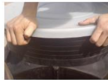
21. kép: DN 624-PE tömítősapka felhelyezése
