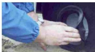
8. kép: Gumitömítés behelyezése
