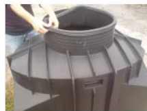
18. kép: DN 624 tömítés felhelyezése
