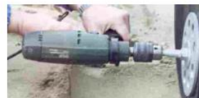
7. kép: Lyukak kivágása koronafúróval
