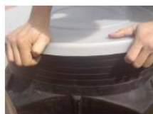
19. kép: DN 650-PE tömítősapka felhelyezése
