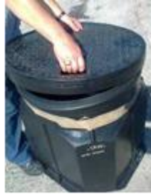
16. kép: Z600/DN624-PE fedél telepítése
