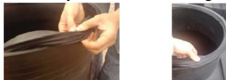
15. kép: DN 624 tömítés felhelyezése
